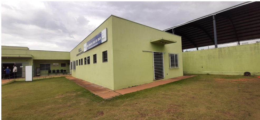
FOTO 4 – FACHADA LATERAL – LOCAL DA AMPLIAÇÃO.
