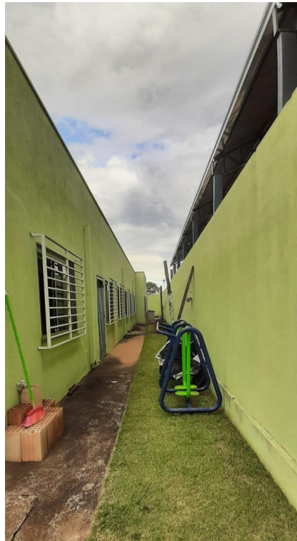
FOTO 3 – FACHADA DOS FUNDOS.
